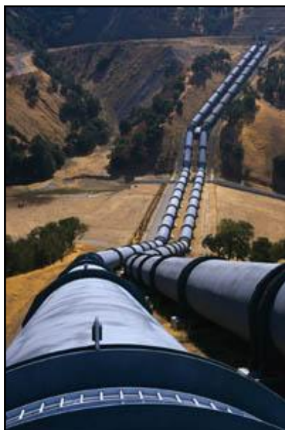
Figura 1 - Tubulações em terreno acidentado [8]
